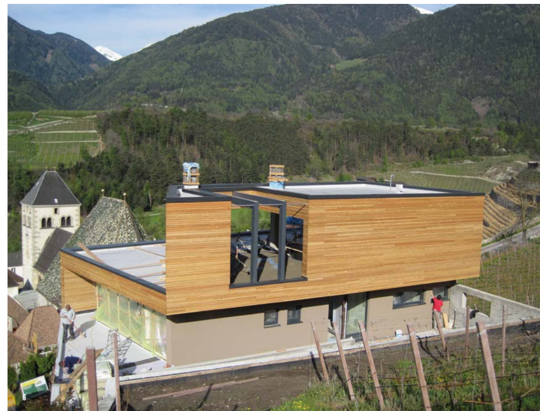
_6 I carichi verticali elevati hanno reso necessario l'uso di pilastri in acciaio, diventati così un elemento caratterizzante, sia statico che architettonico.
