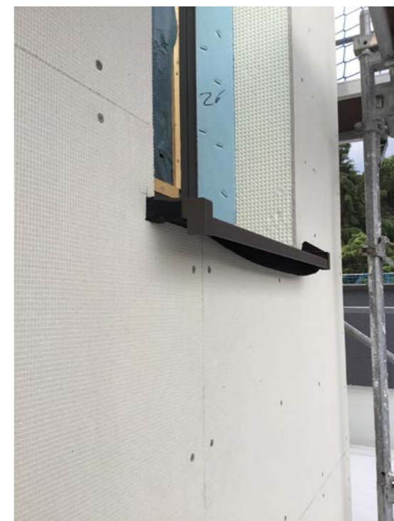
A sinistra, fissaggio della scala a sbalzo sulla parete in X-lam; qui accanto, un particolare del cappotto esterno che risvolta sulla spalletta della finestra e della soglia.
