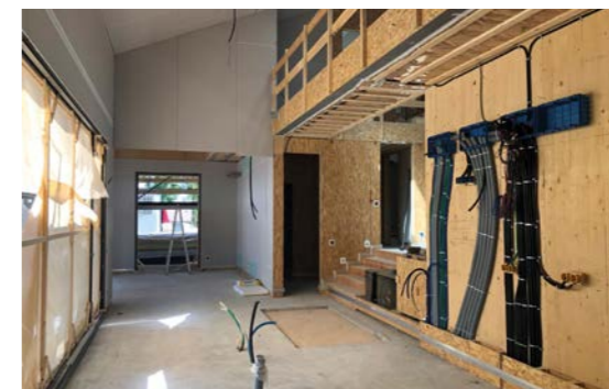
A sinistra, una vista complessiva del cantiere da sud mentre ci si approssima a chiudere il tetto; a destra, un dettaglio dell'allestimento interno degli impianti.
