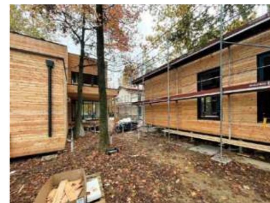
Per preservare l'integrità del bosco non sono stati eseguiti scavi per le fondazioni e non è stata usata la gru per il trasbordo e montaggio degli elementi prefabbricati in legno.
