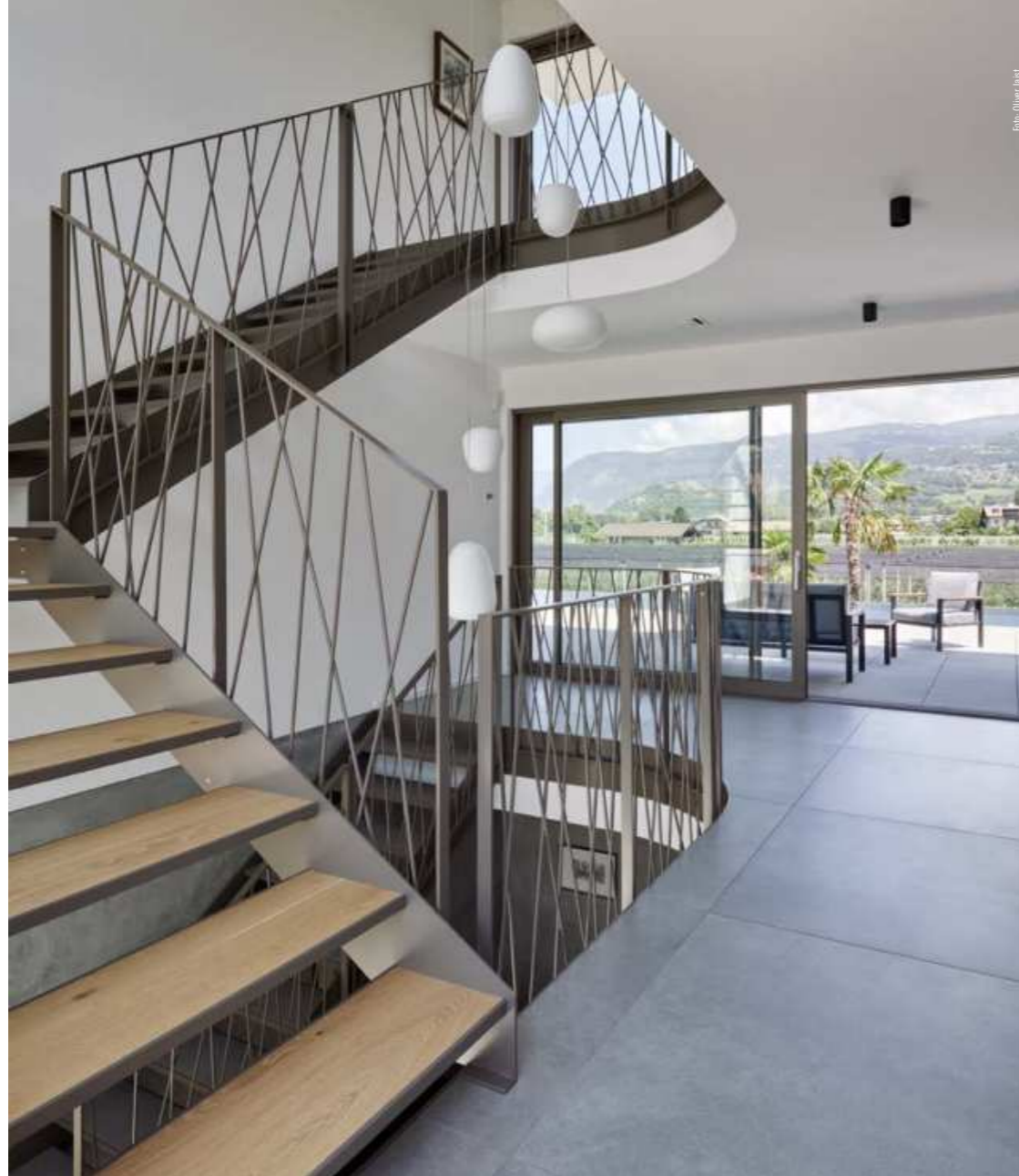
I solai sono stati sagomati per ospitare uno scenografico vano scala, con parapetti e scala autoportante.
