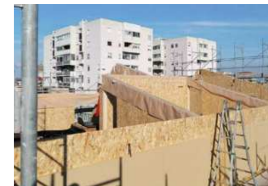
Fasi di montaggio delle pareti di un piano intermedio con solaio e delle pareti dell'ultimo piano predisposte per la posa delle travature.
