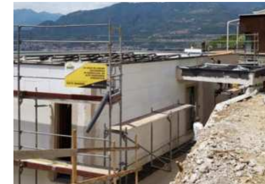
Montaggio del piano superiore e della copertura piana.
