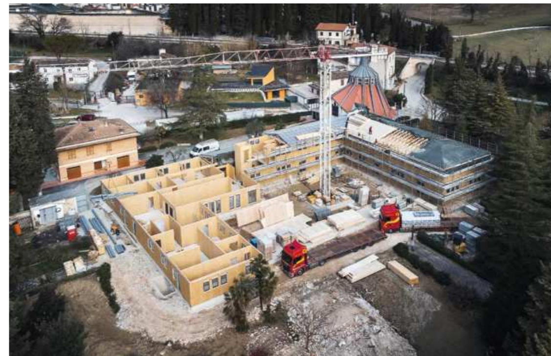
Montaggio dell'ala sud ovest e realizzazione della copertura.
