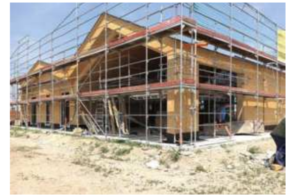
Posa delle capriate della zona notte. Struttura del tetto del portico e installazione del serramento. Diverse soluzioni di copertura nella stessa abitazione.
