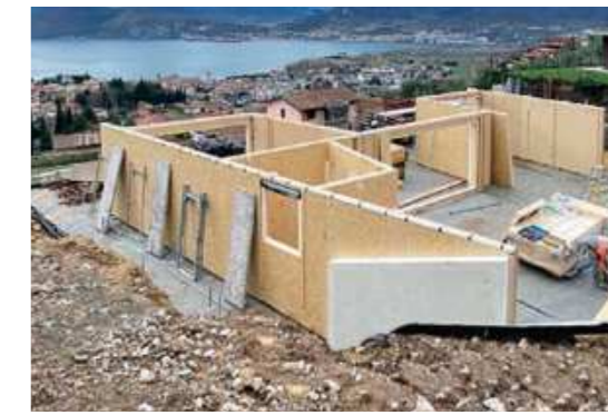
Preparazione del terreno degradante, fondazioni, impermeabilizzazione, realizzazione del muro di contenimento in cemento armato e montaggio del piano seminterrato.
