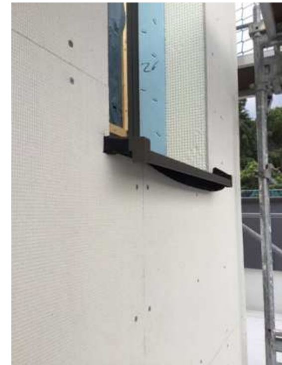
A sinistra, fissaggio della scala a sbalzo sulla parete in X-lam; qui accanto, un particolare del cappotto esterno che risvolta sulla spalletta della finestra e della soglia.
