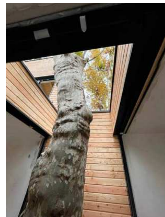
A fianco e a sinistra. Gli alberi ad alto fusto passano attraverso gli edifici e sono visibili dall'interno tramite pareti vetrate con telaio color antracite.
