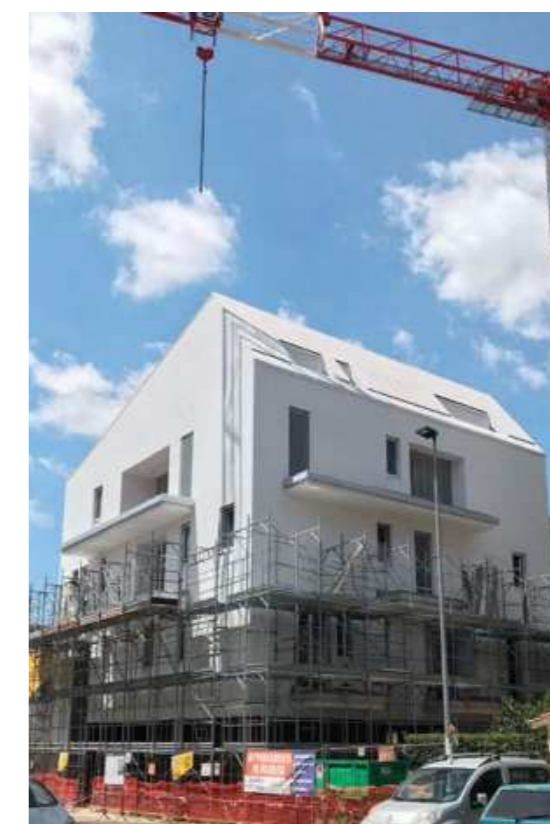
A sinistra, rivestimento della falda con pannelli in fibrocemento ecologico con grondaia integrata e installazione dei pannelli fotovoltaici sul tetto. A destra, vista del cantiere.
