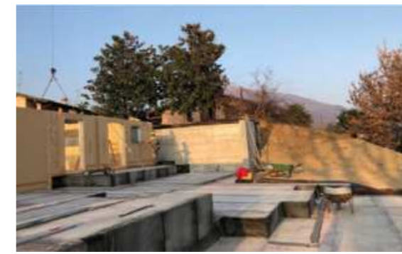
Posa delle pareti prefabbricate del piano terra: a sinistra quelle del livello più alto, a destra quelle con la quota più bassa.
