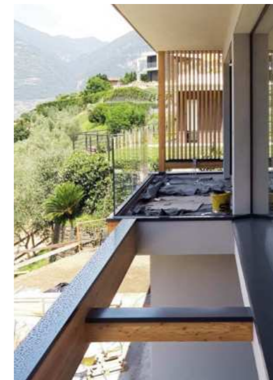
Lavorazioni del prospetto sud-ovest. Posa del parapetto in vetro del terrazzo e del frangisole ombreggiante in legno.
