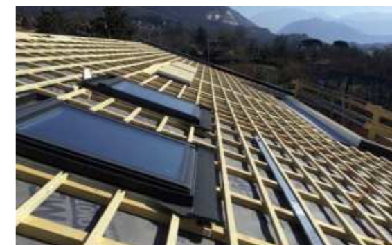
A sinistra, una vista interna della struttura in legno in cui si distinguono l'orditura primaria e secondaria del tetto, le pareti prefabbricate e il ballatoio all'ultimo livello che conduce alle camere. A destra, la copertura con le finestre zenitali e la listellatura in attesa della posa del manto di tegole.
