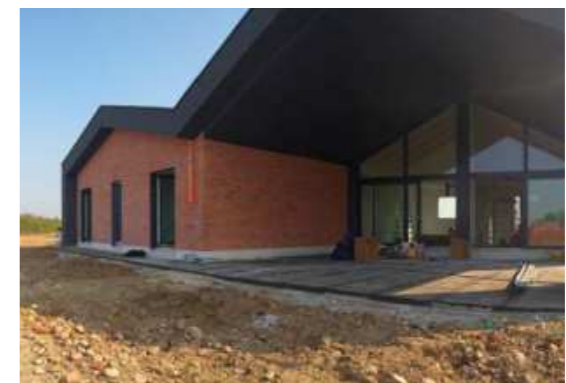
Manto di copertura e canale di gronda in contropendenza, rivestito in pvc.
