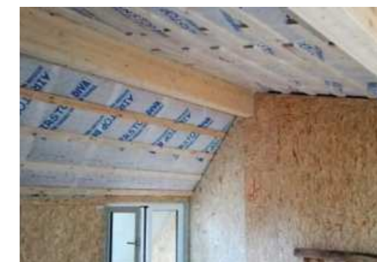
A sinistra, la struttura portante della scala con pianerottolo. A fianco, la struttura del tetto, con isolante, vista dall'interno dell'alloggio prima della posa del cartongesso e il lucernaio della scala comune.
