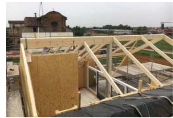
Fase di posa delle pareti perimetrali e orditura del tetto a vista del living.
