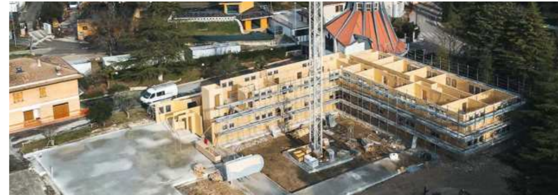
Montaggio della struttura lignea dell'edificio in adiacenza alla chiesa in cemento armato.
