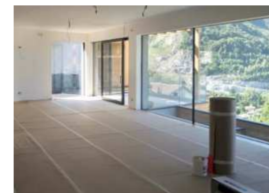
Prospetto sud-est. Open space del piano superiore completato con telo di protezione per il pavimento in legno.
